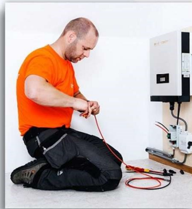
Omvormer en kabeltraject
